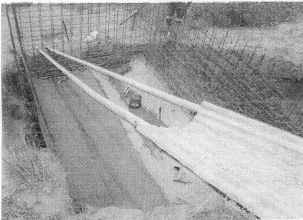
MACILLADO DE PISO
