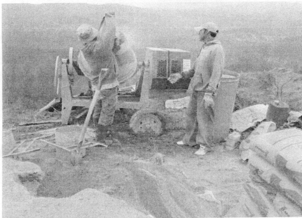
REALIZACION DEL HORMIGON
