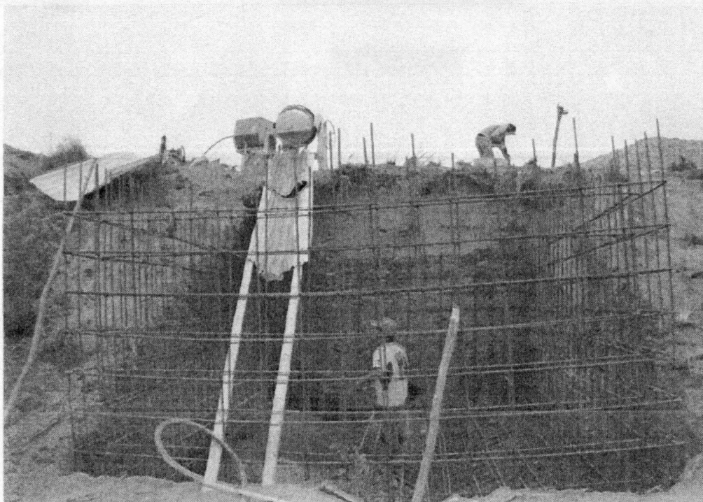
FUNDICION DE HORMIGÓN DE PISO f_c = 210 \text{ Kg/cm}^2
