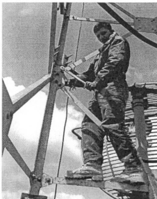
AJUSTE DE PERNOS TORRE 30 M.
