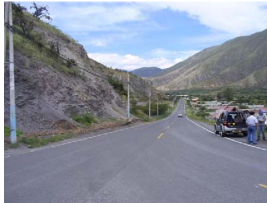
Figura 1. Vía de ingreso a la Cabecera Parroquial de Ambuquí
