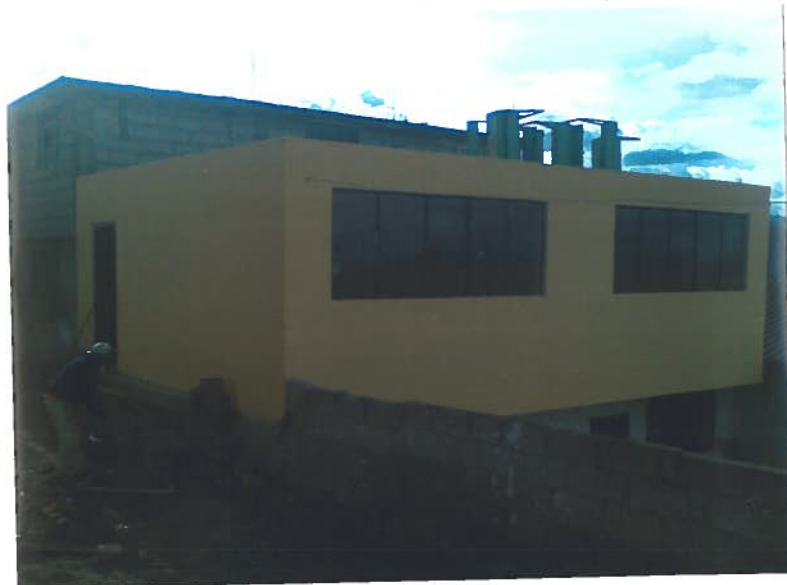
LIMPIEZA DE LA OBRA
