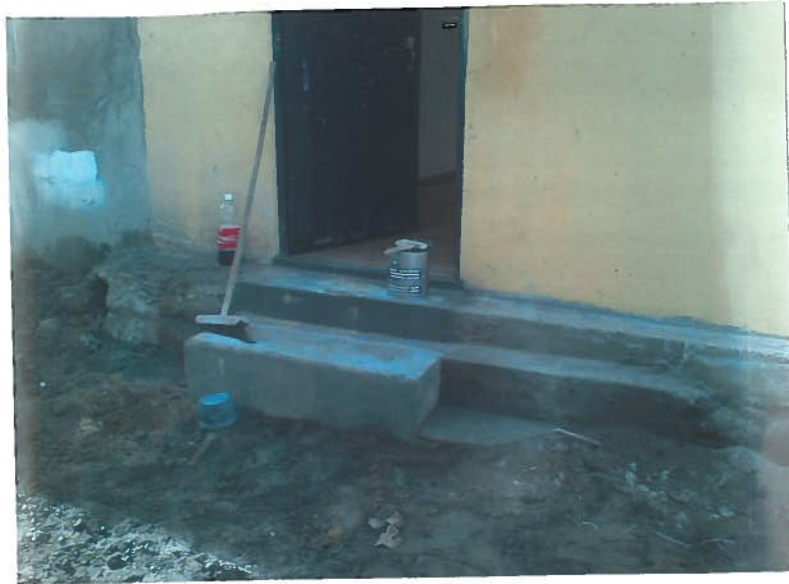
CONSTRUCCION DE GRADAS
