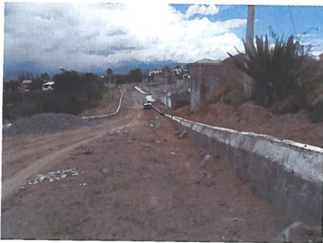
RELLENO COMPACTADO CON SUELO DE PRESTAMO
