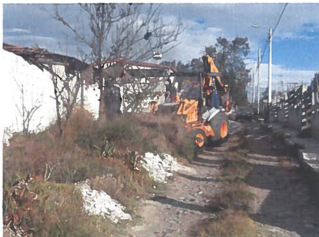
DESBANQUE Y RASANTEO PASAJE
