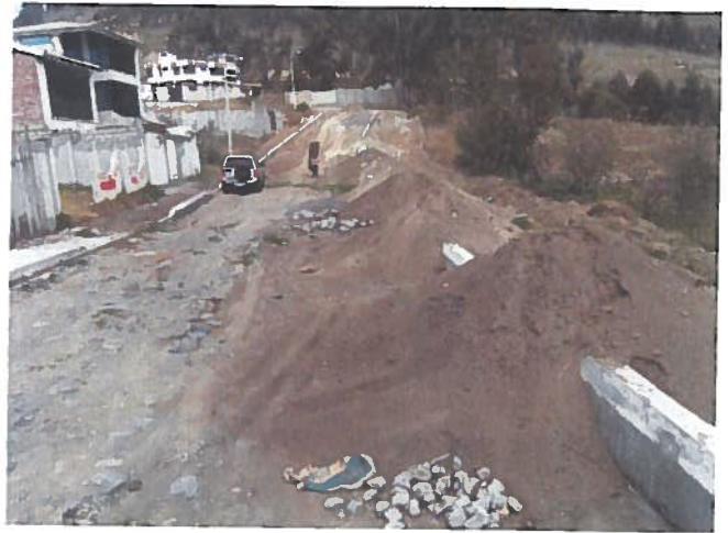
RELLENO COMPACTADO CON SUELO DE PRESTAMO
