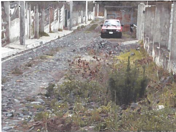
DESBANQUE Y RASANTEO PASAJE
