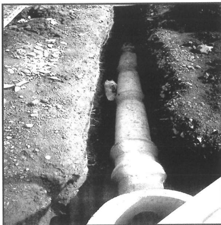
COLOCACION DE TAZA PARA SUMIDERO Y TENDIDO DE TUBERIA PARA ALCANTARILLADO (Diámetro 20 cm.)
