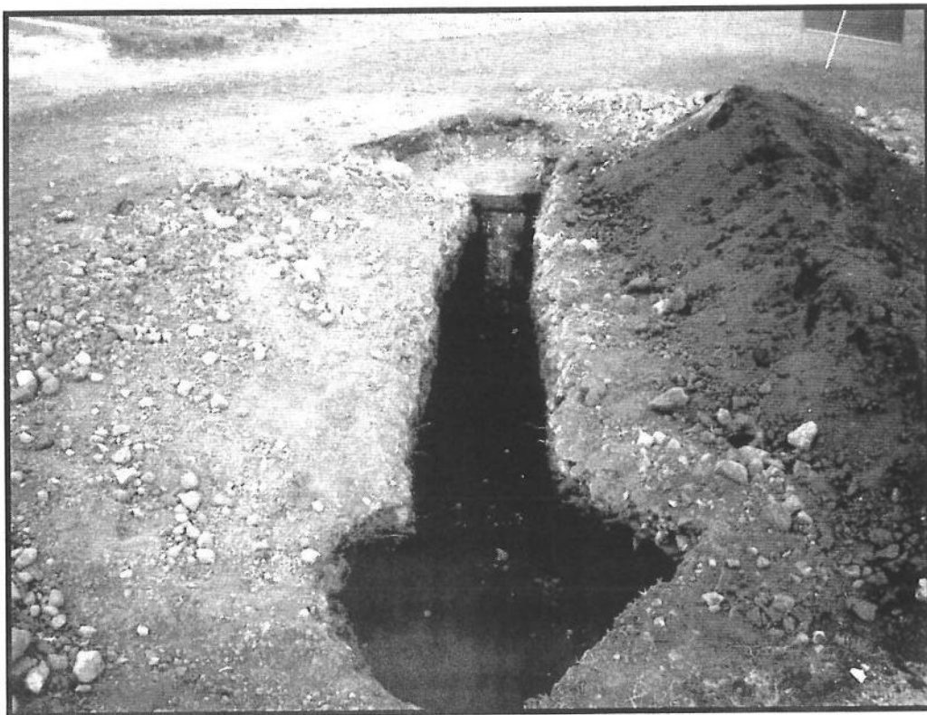
EXCAVACION PARA CONSTRUCCION DE SUMIDERO Y TENDIDO DE TUBERIA PARA ALCANTARILLADO (Diámetro de 20 cm.)
