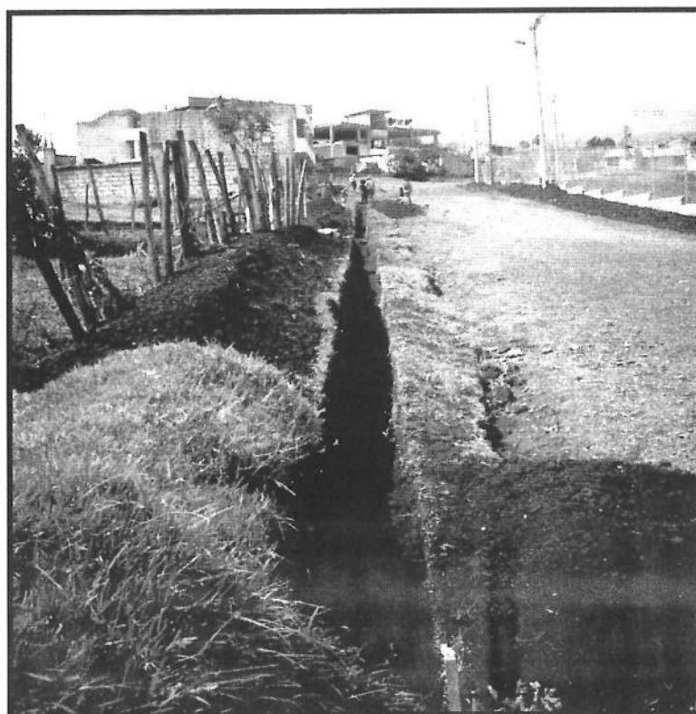
EXCAVACION PARA BORDILLO DE HORMIGON
