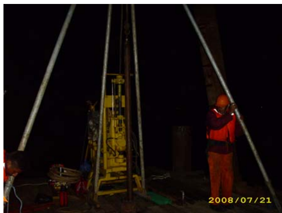
Colocación de revestimiento para la perforación en PA-8
