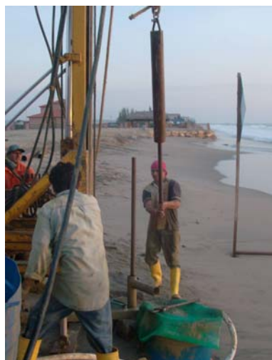
En la perforación PA-10 realizando ensayo de SPT con el martillo Safety
