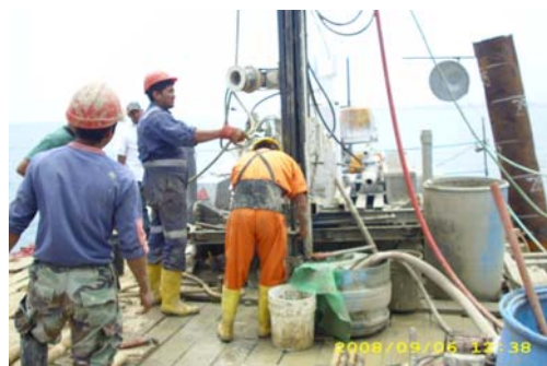
Plataforma de perforación en PA-3 con máquinas Symco 2400 y Craellius
