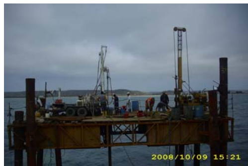
Vista de la plataforma de perforación en PA-5, máquinas Symco 2400 y Craellius
