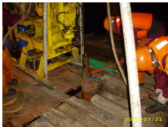
Colocación de revestimiento para la perforación en PA-8
