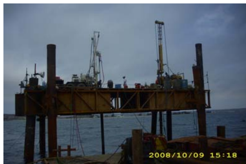
Vista de la plataforma de perforación en PA-5, máquinas Symco 2400 y Craellius
