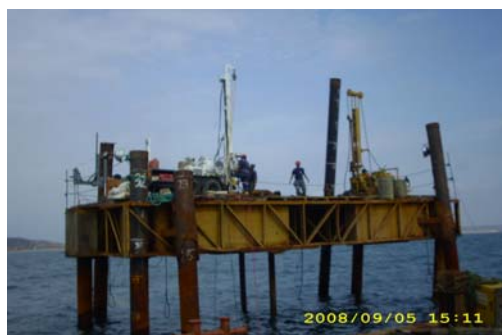
Plataforma de perforación en PA-3 con máquinas Symco 2400 y Craellius
